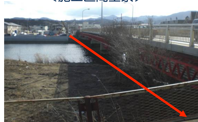
＜施工区間全景＞
