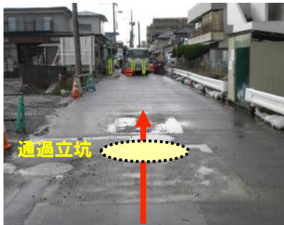
■ 通過立坑ヘッド交換
