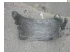
■ 鋼製カラー破碎状況
