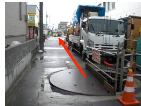
■ 発進立坑状況
