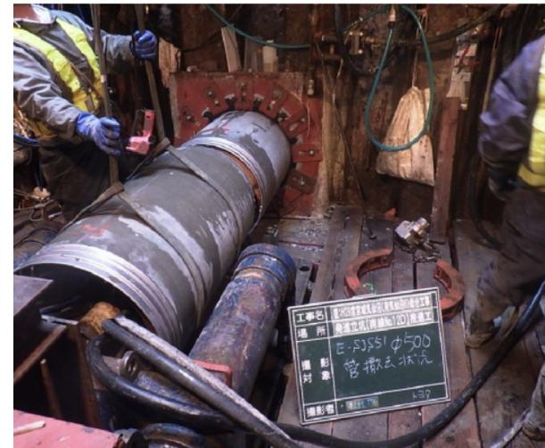
本工法は、老朽管や不良管の敷設替えは元より、既設管の撤去にも対応できるため不要管等の撤去技術として適用可能です。
