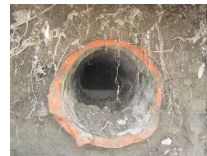
■ 既設陶管の埋設状況
