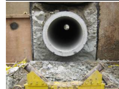
■ 推進完了（発進側）
